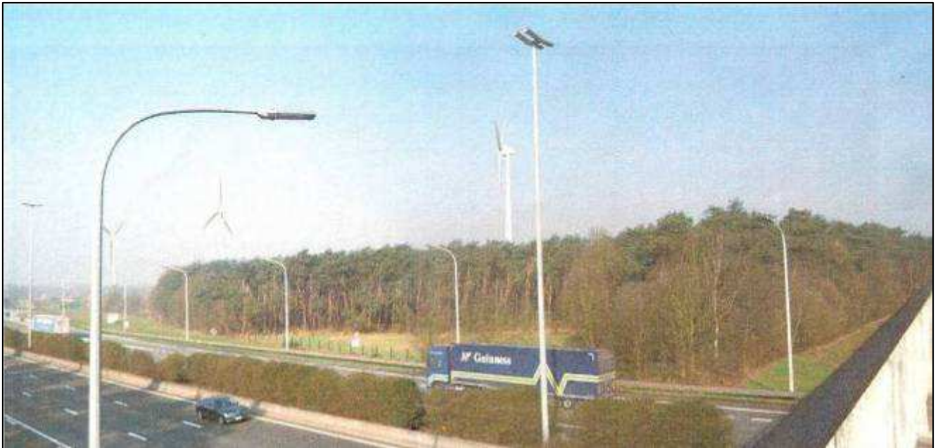
Beeld van op de brug (aan parking) over de E17.
