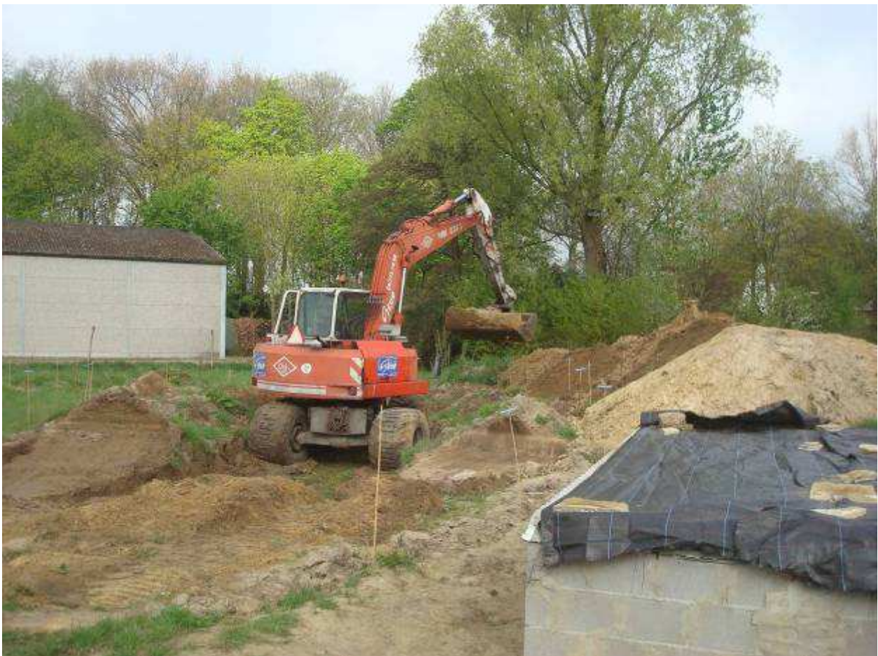
Belle kan starten met het graafwerk...
